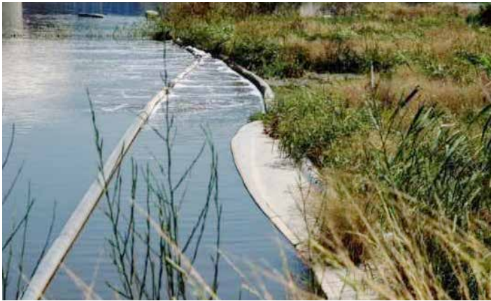
Резервуар для сточных вод для оксигенации воды Project-Emek Hefer.
