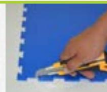
3. При укладке обращать внимание, что все половицы Sensor должны быть сориентированы таким образом, чтобы углы с элементом замка в виде стрелки были направлены в одну сторону (для замка «ласточкин хвост»).
